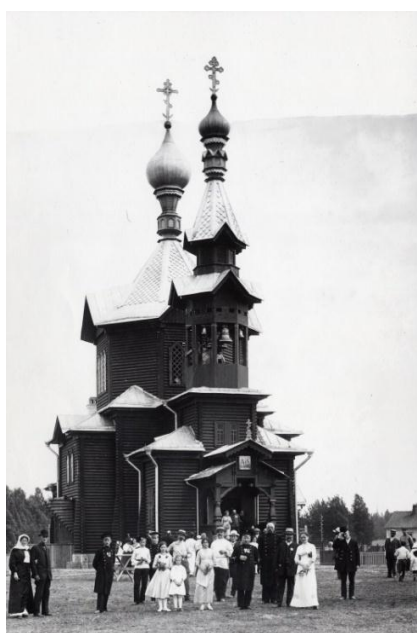
Рис. 13. Храм Преображения Господня в поселке Мустамяки, ныне п. Яковлево у станции ж/д Горьковское. Храм разрушен в войну 1939-1941 гг.
